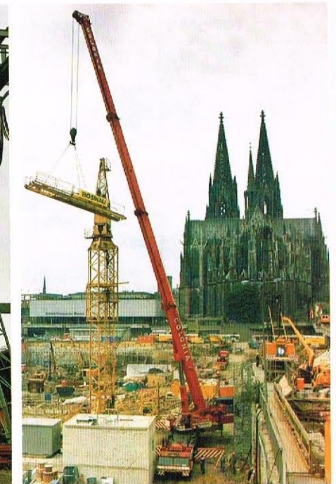
GOTTWALD AMK 200-83, 200/230 t Tragfähigkeit
