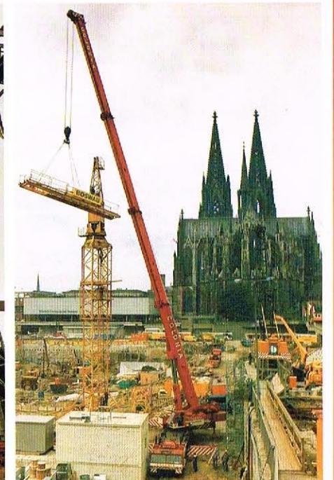
GOTTWALD AMK 200-83, 200/230 t Tragfähigkeit
