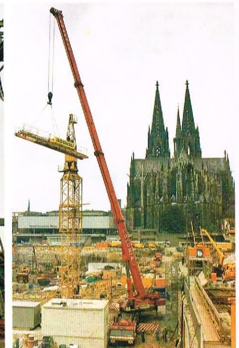
GOTTWALD AMK 200-83, 200/230 t Tragfähigkeit
